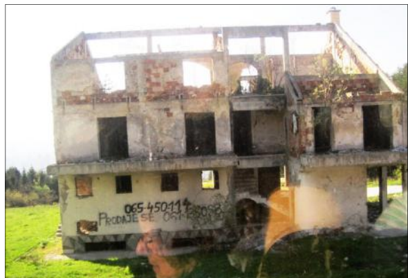
Im Krieg 1997 zerstörtes Haus nahe bei Sarajewo
